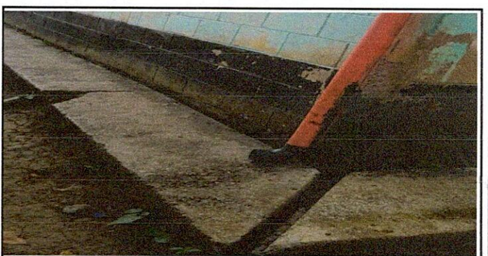
Foto 6: Reparación de tubo hg y malla galvanizada
