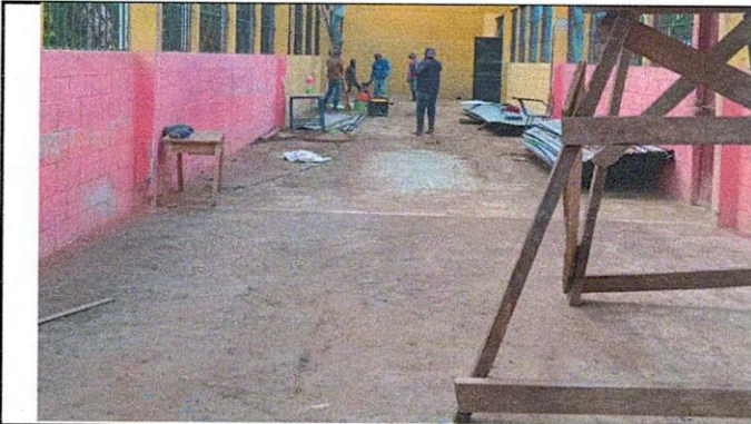
Foto 3: Reparación de piso
